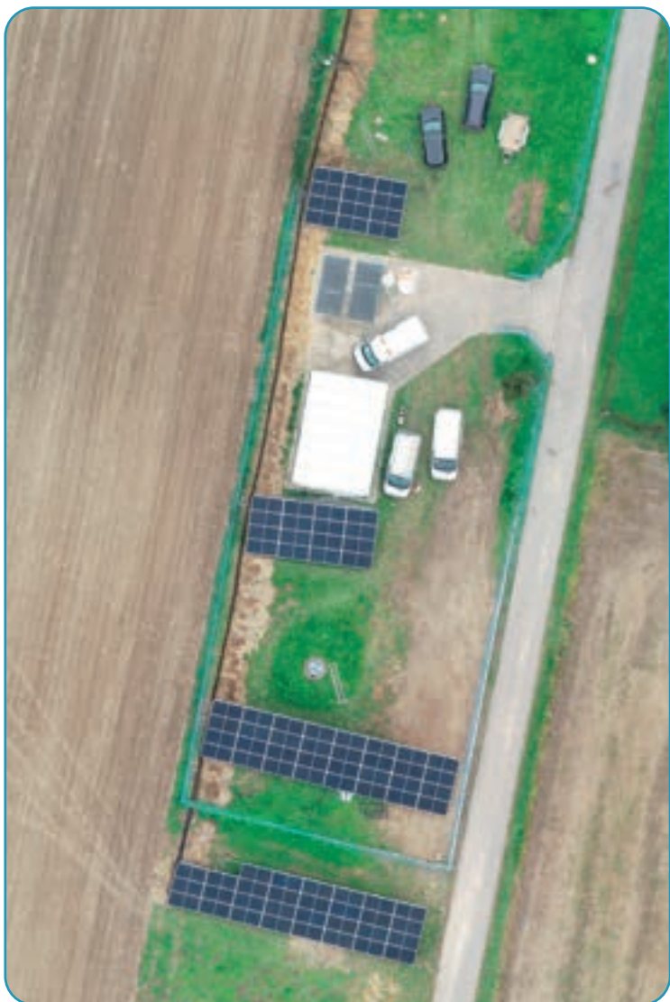
Farma na Stacji Uzdatniania Wody 1 Szarów – rok budowy 2023
